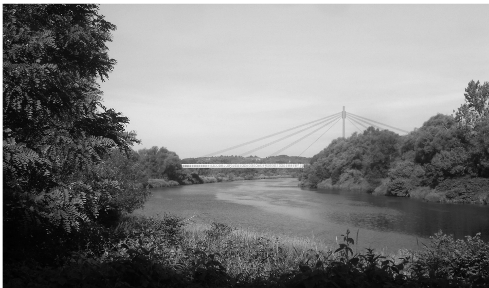
Fot. 15. Rurociąg doprowadzający do Krakowa wodę ze zbiornika na Rabis w Dobczycach; po lewej stronie widoczna ścieżka rowerowa biegnąca wałami Wisły. Fot. J. Pociask-Karteczka
