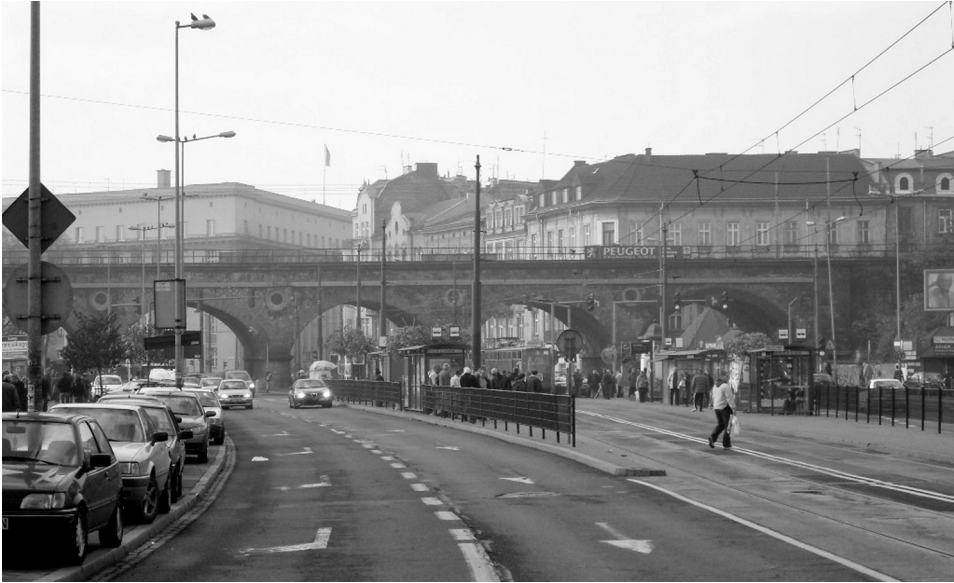
Fot. 1. Wiadukt kolejowy przy ulicy Grzegorzewskiej pełniący niegdyś funkcję mostu na Starej Wiśle (obecnie element Krakowskiego Szlaku Techniki utworzonego 6 kwietnia 2006 r.).
