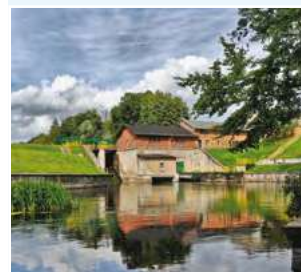
▲ Elektrownia wodna w Kamiennej (fot. A. Łąkowska)
