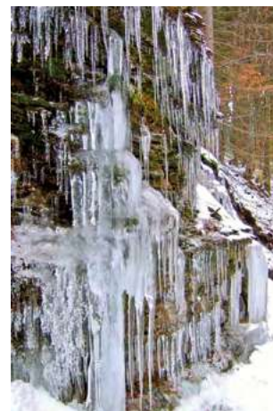
▲ Wycieki ze szczelin w piaskowcach (fot. P. Jokiel)
